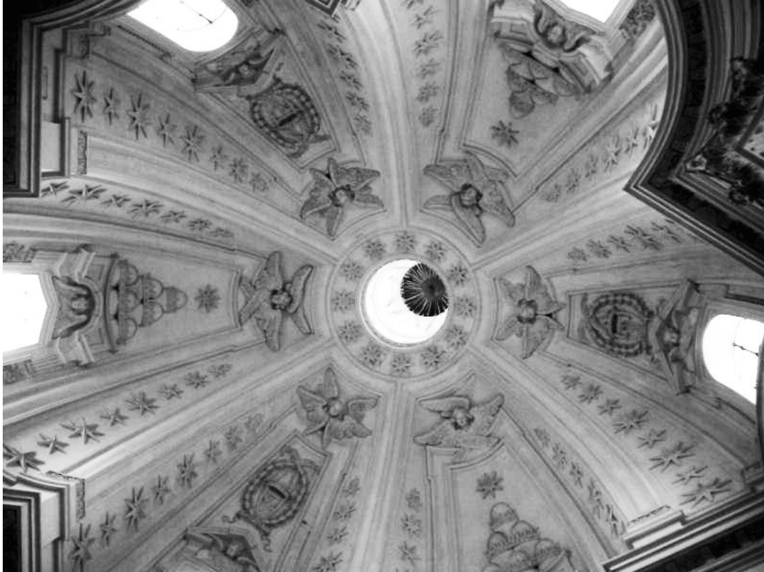
Figure 11 Dome of St. Ivo alla Sapienza (internal)
