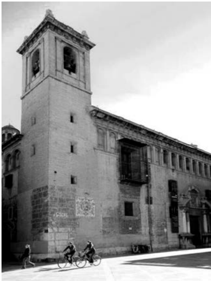
Fig. 1. Fachada principal de ingreso al Colegio del Patriarca de Valencia.
