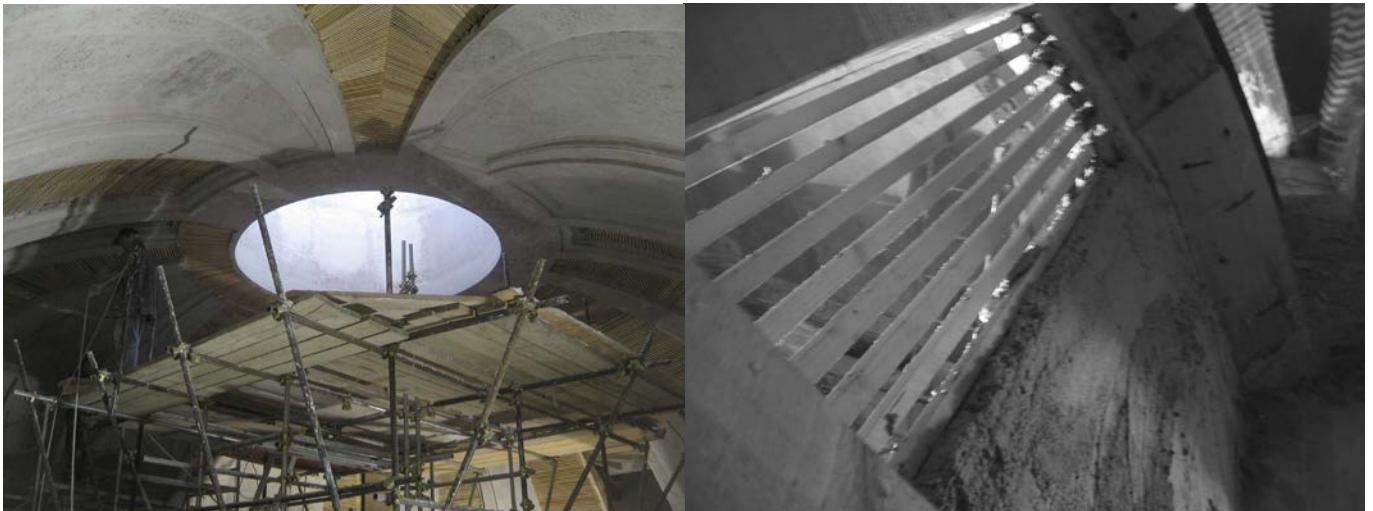
Fig. 24. Plastering the vault
