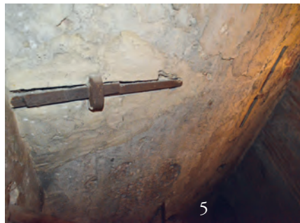
1. Intercapedine tra le due calotte – 2. Apparecchiatura muraria dove è mancante l'intonaco 3.-4. La salita fino alla lanterna – 5.-6. Le catene metalliche. Foto di Vincenzo Vaccaro.
