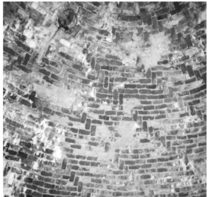
Cupola della Rondella Grande Nord-Ovest del Forte di Sarzanello.
