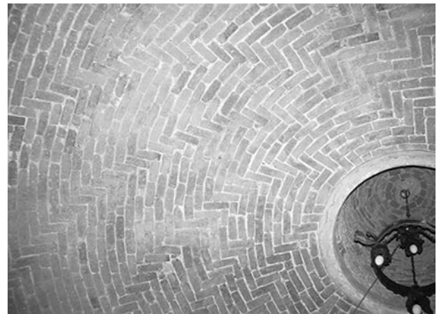
Cupola emisferica inserita nel Torrino di spigolo della Cinta Muraria di Pietrasanta.
