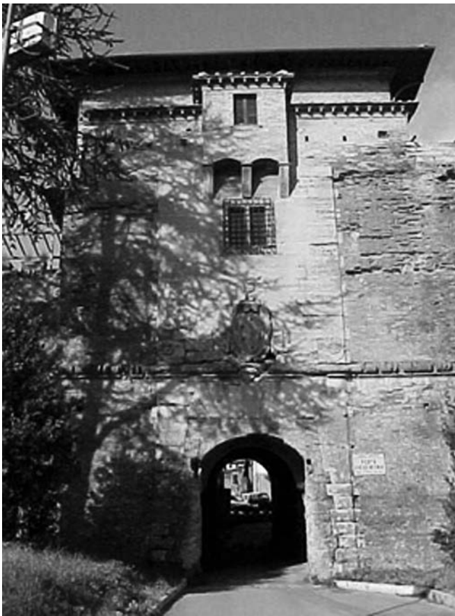
Vista esterna della Porta Fiorentina della Fortezza di Terra del Sole.
