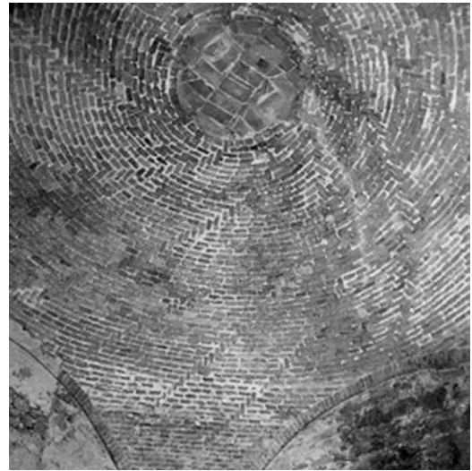
Cupola emisferica inserita nella Sala del posto di guardia nella Fortezza di Poggio Imperiale a Poggibonsi.
