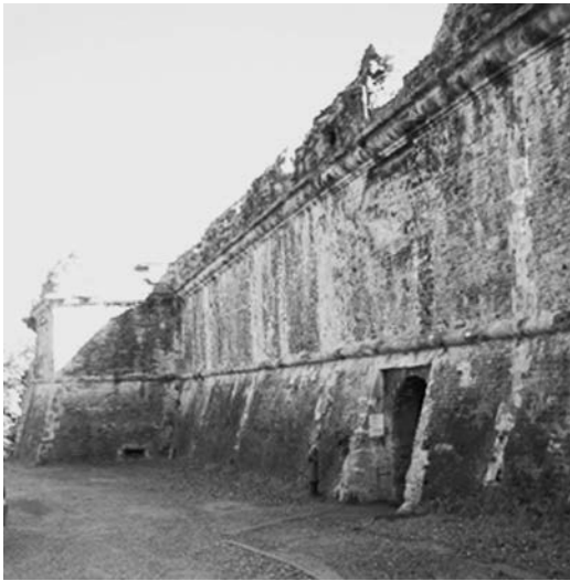
Vista esterna dell'ingresso alla Sala del posto di guardia nella Fortezza di Poggio Imperiale a Poggibonsi.
